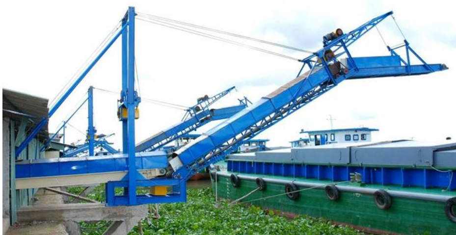
Lắp dựng Hệ thống Băng tải vận chuyển
