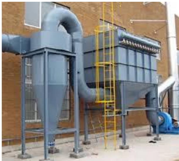
Hệ thống lọc bụi túi vải rung giữ khí nén
