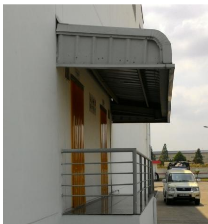
Mái đón nhà kho
