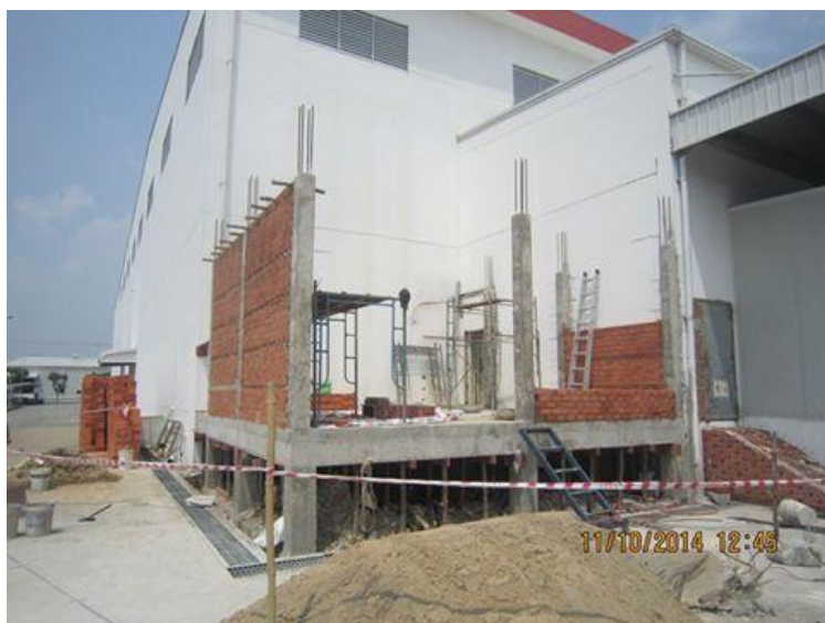
Nhà kho xây dựng mở
