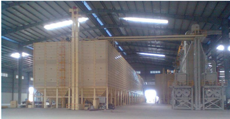
Lắp dựng Hệ thống Si lô chứa lúa gạo
