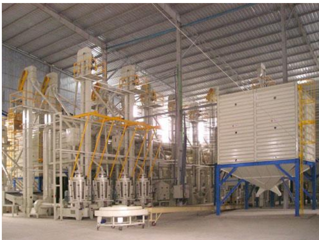
Lắp đặt dây chuyền xay xát lúa gạo
